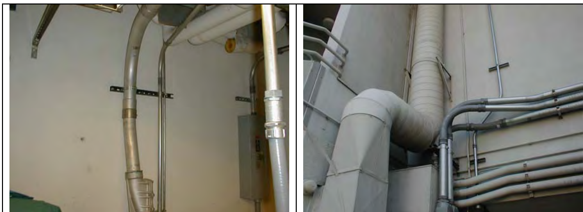
תפיסה של צנרת ותעלות מיזוג אוויר לקיר. בית חולים קייסר פרמנטה - פנורמה סיטי. (מרץ 2004)
