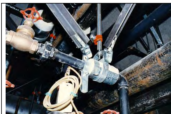
חיבור אורכי על ידי מוט דו-פרקי בקצה קטע קו
